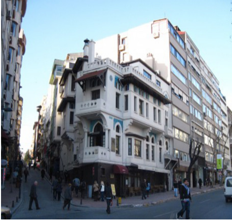
Resim 5: Mimar Vedat (Tek) Evinin Cephe Görünüşü (URL-4)
